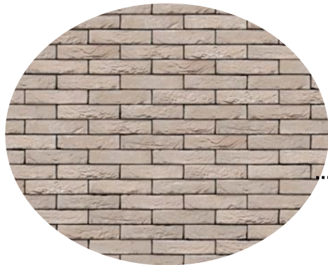
Brique de teinte claire, avec joint vif
